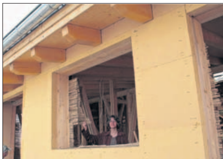
Architektin Susanne Obermeyer (l.) zeigt die Füllung aus Lehm und Hanf, mit der die Wände des Lehmhauses im Neubaugebiet Nord verfüllt werden. Die Schilfrohmatten der Schalung werden mit einer Heckenschere angepasst, die Füllung wird Eimer für Eimer eingebaut (Bilder oben). Außen erhält das Haus eine Haut aus Holzfaserschalen, der Turm wird verschindelt. Bilder: hje
