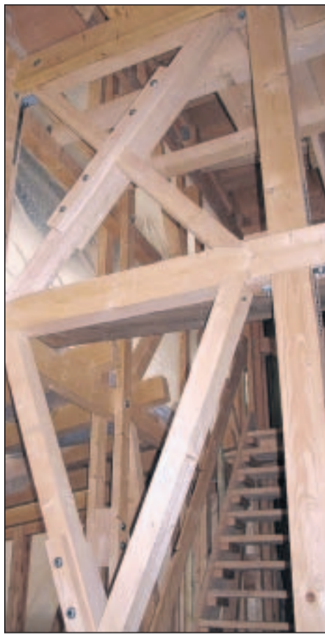
Auch im Innern wartet das Gerippe aus Holz auf seine Ausfachung.
